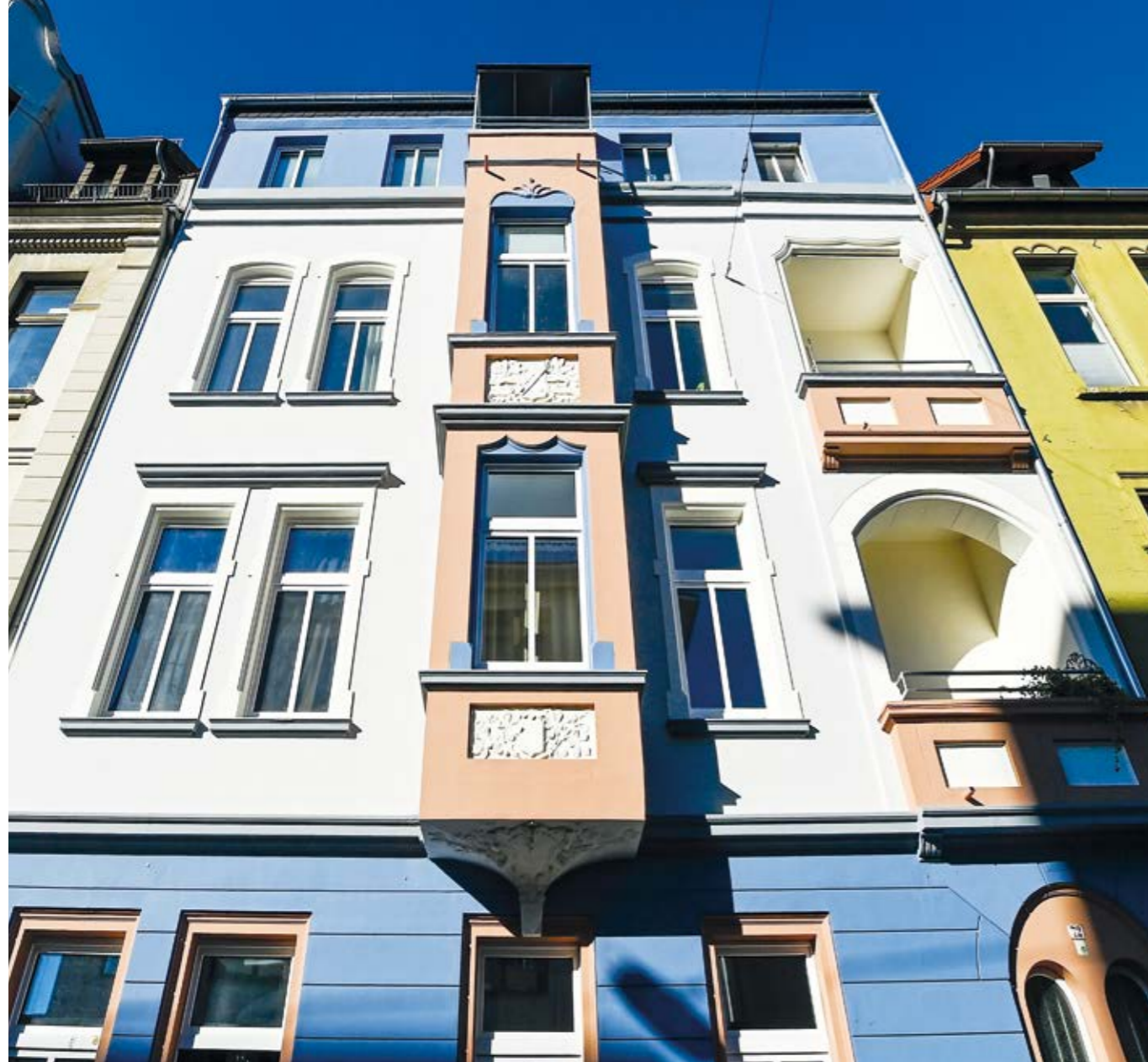
Bei der Modernisierung des Altbaus an der August-Bebel-Straße 72 hat die BGW die historische Schmuckfassade erhalten.
