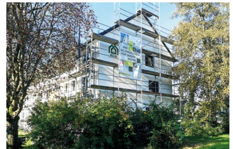
An der Von-Möller-Straße in Brackwede wurden weitere 36 Wohnungen auf den neuesten Stand gebracht.
